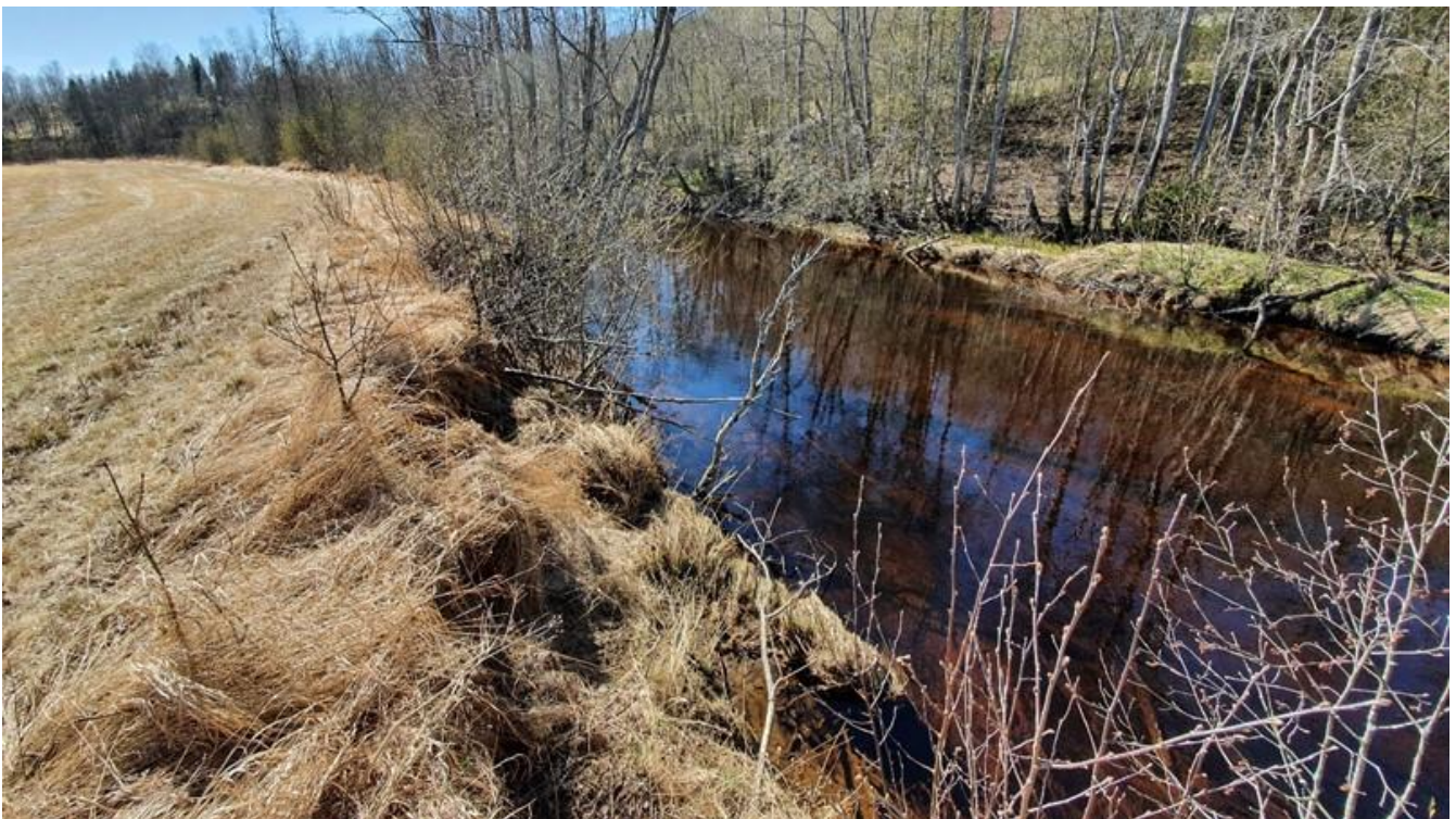
Figur 3-16. Erosjonssikring elvekant – Nordre Ringerike. 2.2.
