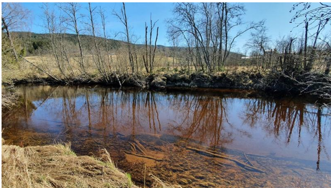
Figur 3-11. Yttersving ved Holtet og Bakk. Elvekanten er utsatt for erosjon i yttersving. Svingen er sårbar for erosjon, særlig dersom større trær på elvekanten vipper ut og danner en stor åpen rotvelt ned i elva.
