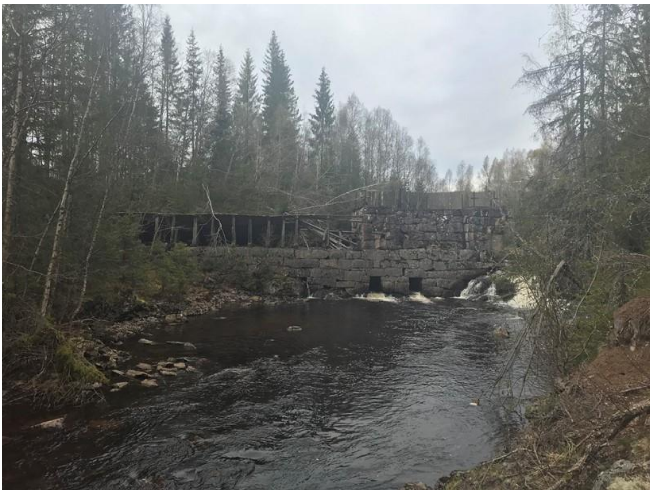
Figur 3-28. Kulturminne med demning ved Sloradammen i øvre deler av Heggelielva.
