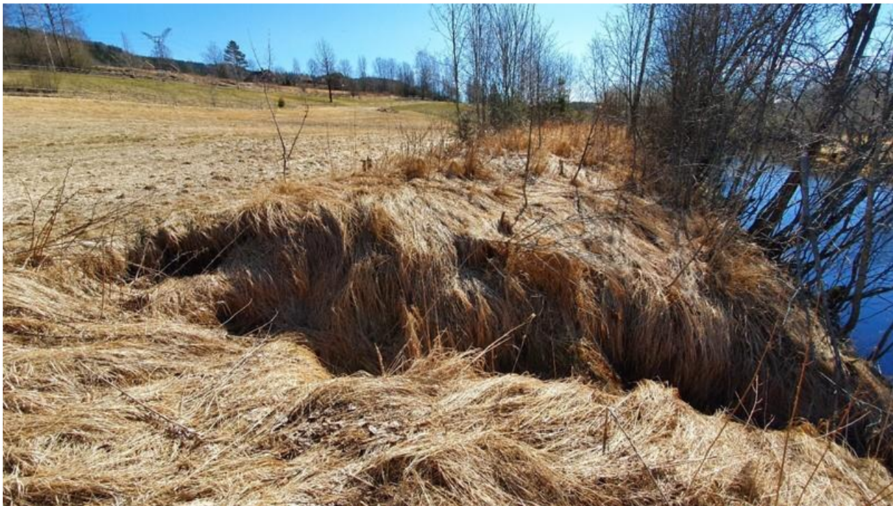
Figur 3-13. Erosjon og tilbakegraving rundt rørutløp ved Ringerike. Foto: 20.04.2020.
