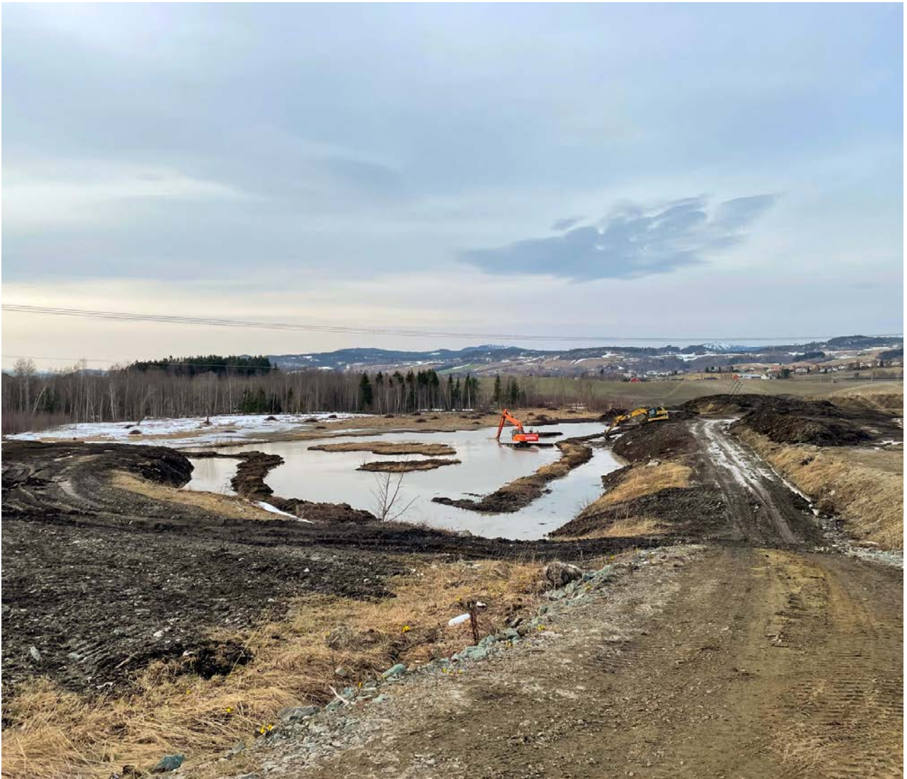
Naturrestaurering i Trondheim, tilbakeføring til våtmark pga mislykket oppfylling ved E6. Foto: Ana Nilsen, RKL
